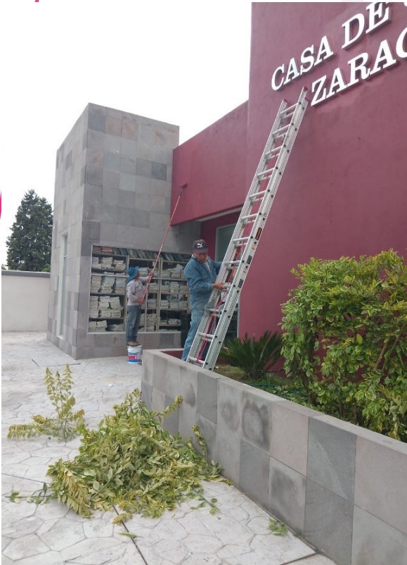
Mantenimiento a la fachada principal del Juzgado de Zaragoza.
